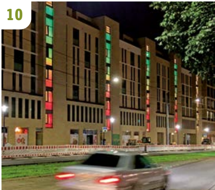
Leuchtkraft: Neue Gebäude werden mit LED-Technik ins beste Licht gerückt.
