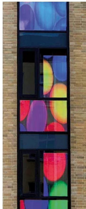
In mehreren Testläufen wurden die in den Treppenhäusern unserer Neubauten im Breiten Weg installierten LED-Bildschirme mit verschiedenen Mustern und Farben bespielt.
